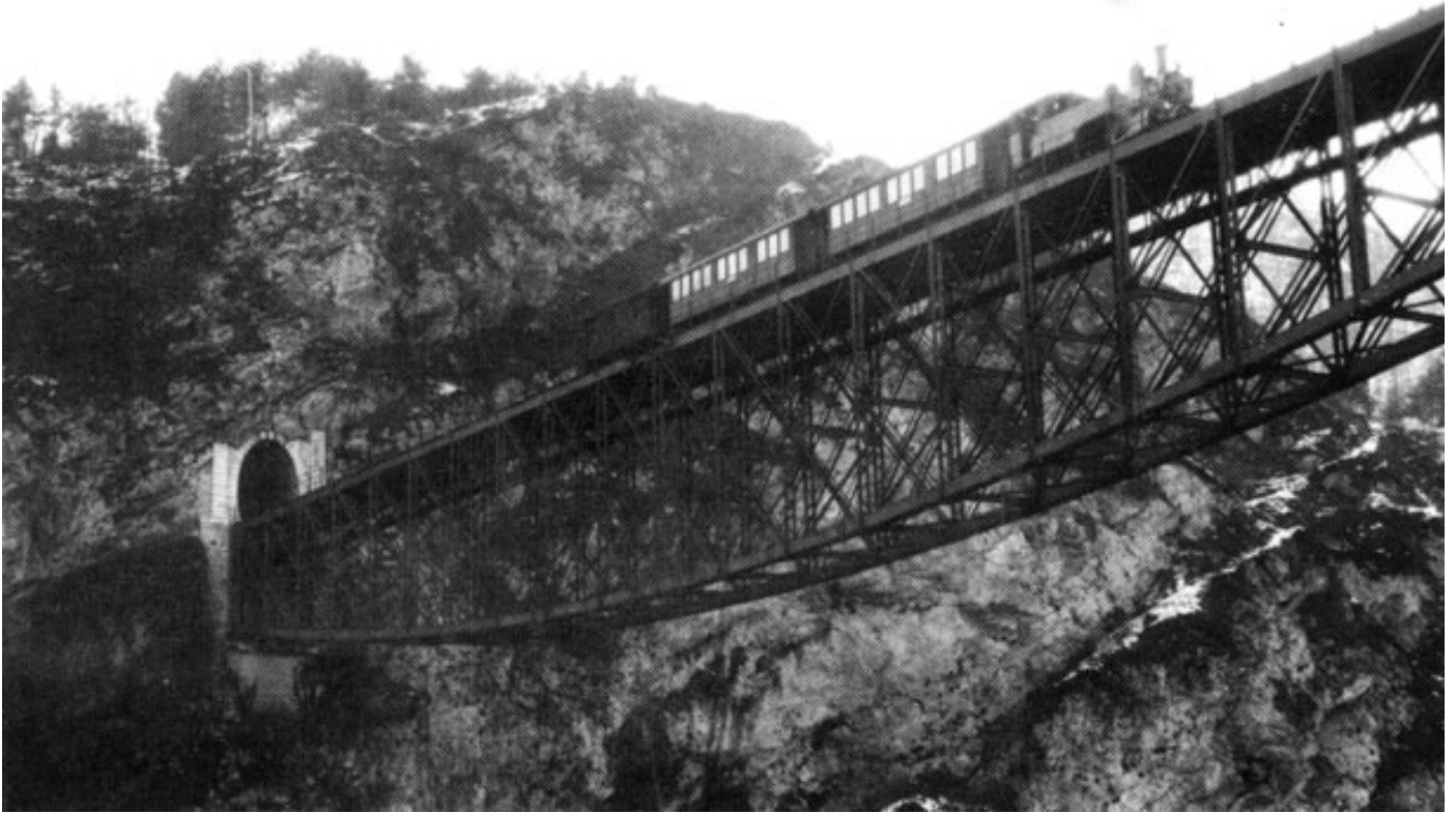
Ferrovia Piovene Rocchette Asiago. Ponte viadotto sull'Astico alto 73 metri.
