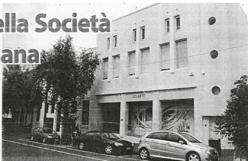
La residenza del Coasit nel quartiere di Carlton
